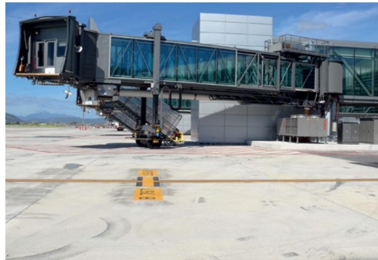
Instalación de siete pasarelas de embarque y equipos auxiliares para la T2 del Aeropuerto de Málaga-Costa del Sol. España.
