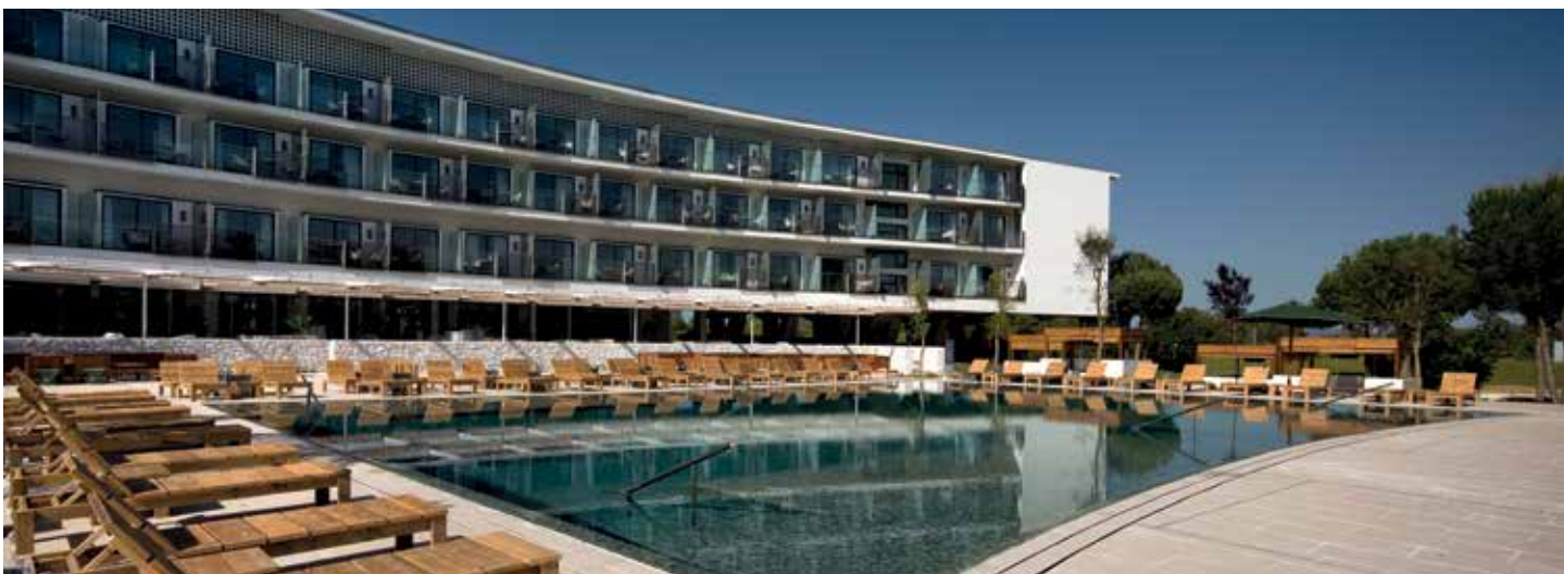
Remodelación del Hotel PGA Catalunya Resort de Caldes de Malavella, Girona, España Refurbishment of the PGA Catalunya Resort Hotel at Caldes de Malavella, Girona. Spain
