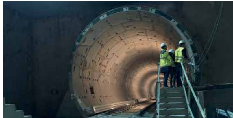
Prolongación de un tramo de catenaria de la línea de ferrocarriles de Sabadell. España Extension of the overhead contact line on the Sabadell railway line. Spain
