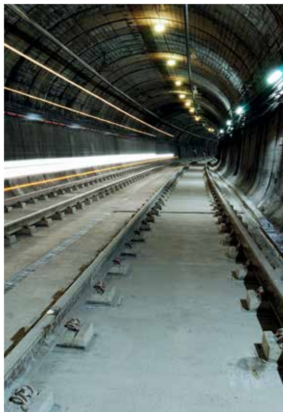
Mantenimiento de vía y estaciones en diferentes líneas del Metro de Madrid. España Maintenance of track and stations of several lines of the Madrid Metro network. Spain
