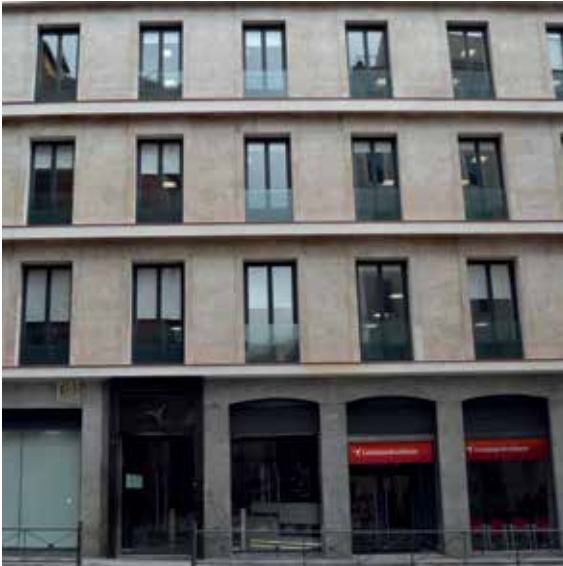
Mantenimiento integral del Edificio de Catalana Occidente en Madrid. Comprehensive maintenance of the Catalana Occidente building in Madrid.
