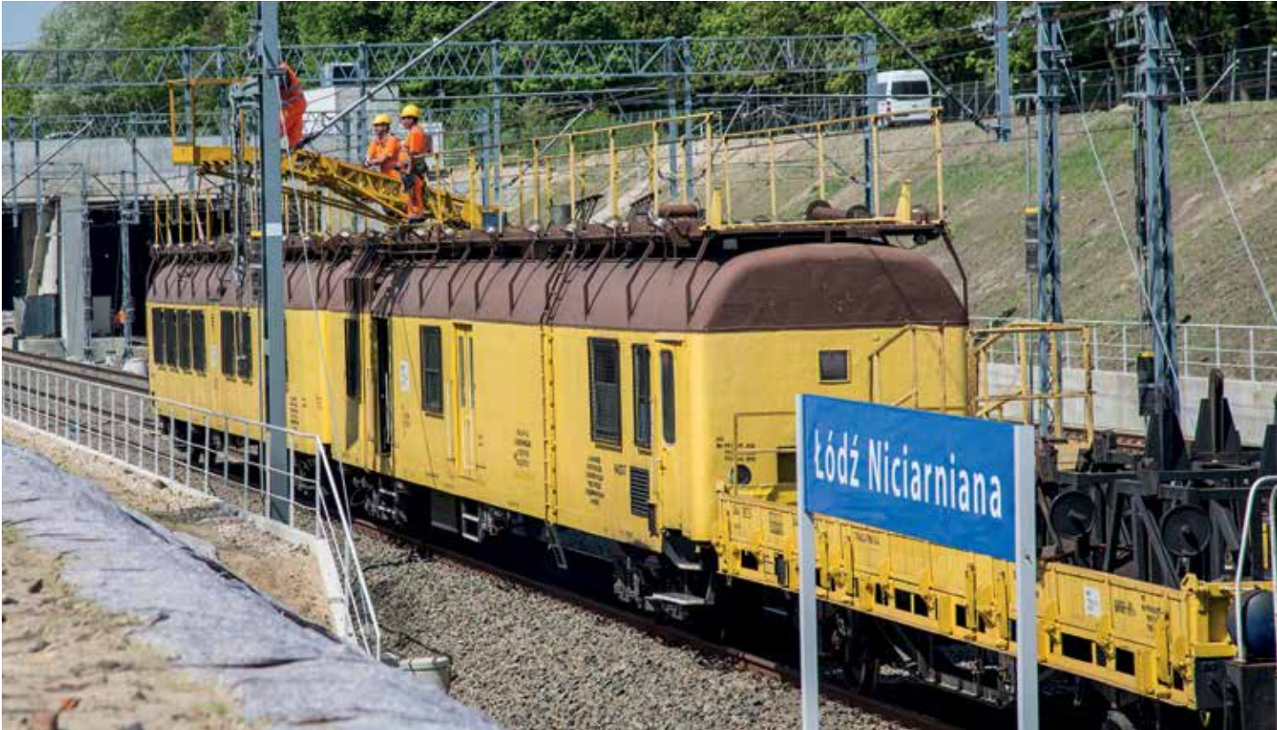
Construcción de la estación Lodz Niciarniana, Polonia Construction of the Lodz Niciarniana railway station, Poland
