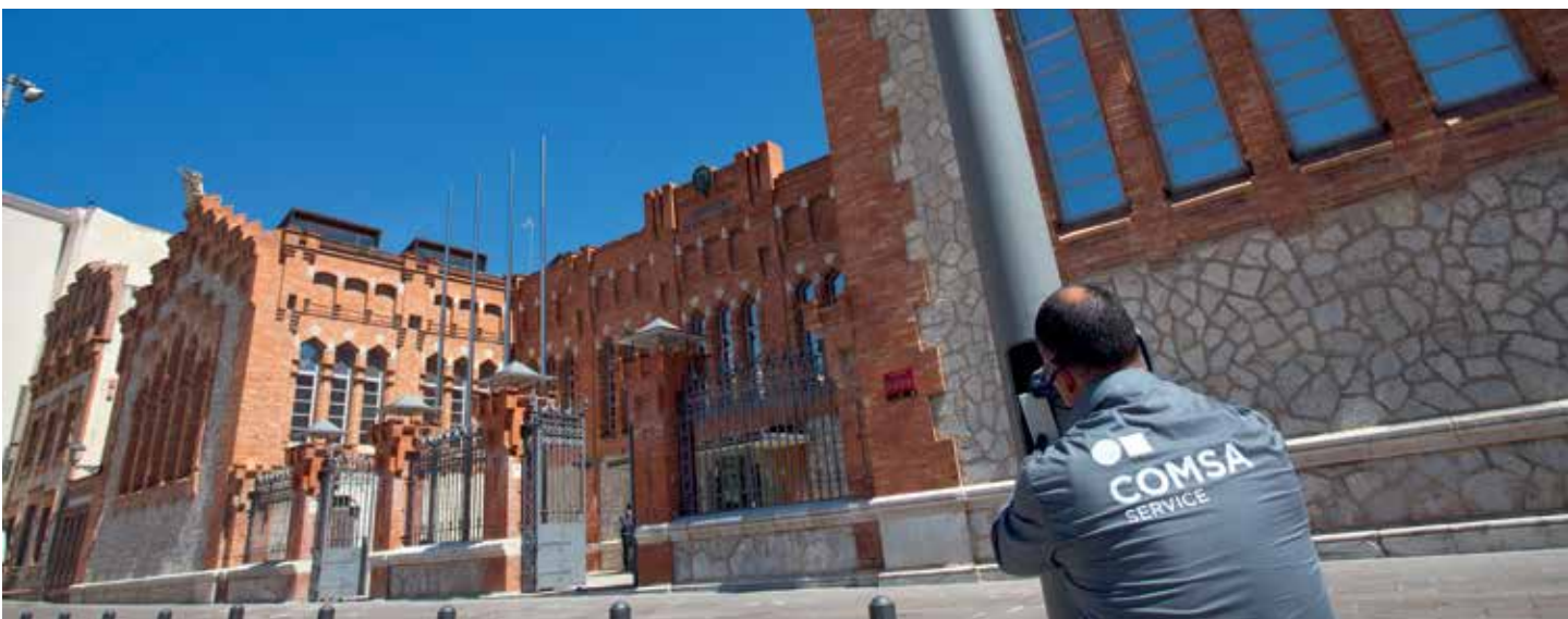
Mantenimiento integral de los edificios de la Universidad Rovira i Virgili (Tarragona). Comprehensive maintenance of the buildings of Rovira i Virgili University (Tarragona).
