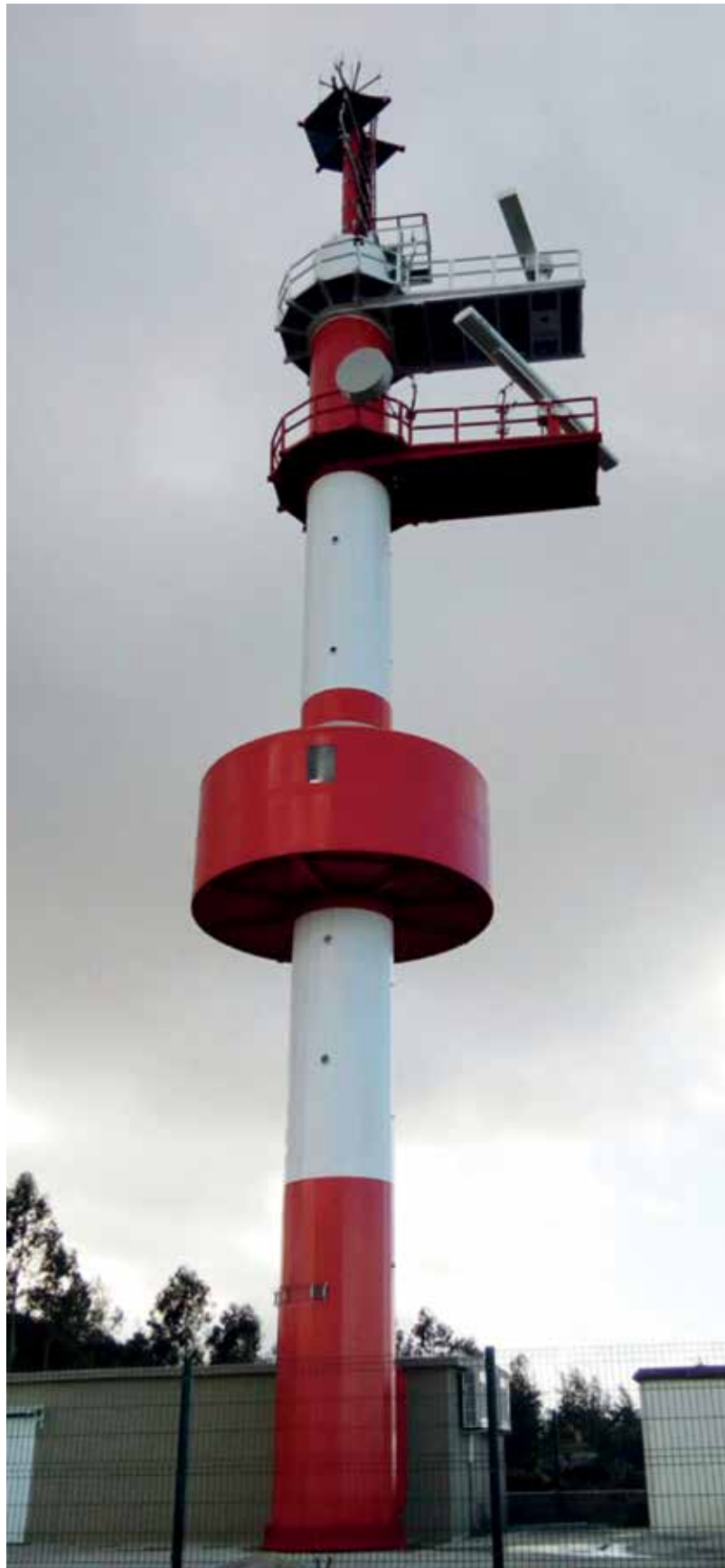
Equipamiento electrónico del Centro de Coordinación de Salvamento Marítimo de Vigo. España Electronic equipment for the Maritime Rescue Coordination Centre of Vigo. Spain
