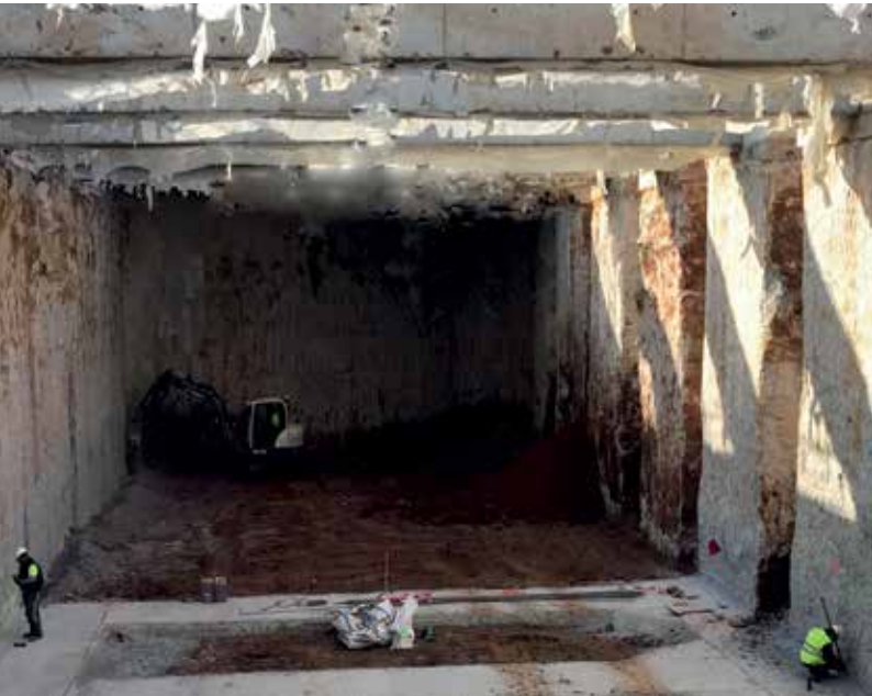
Construcción de los túneles viarios de la Plaza de las Glorias de Barcelona, España Construction of road tunnels under the Plaza de las Glorias in Barcelona, Spain
