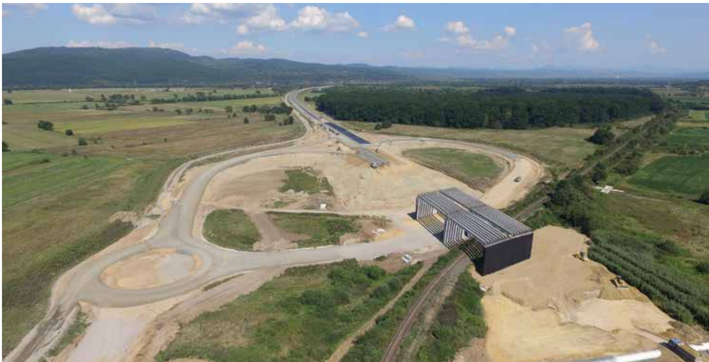
Construcción de un tramo de la autopista Lugoj - Deva, Rumanía Construction of a section of the Lugoj - Deva highway, Romania
