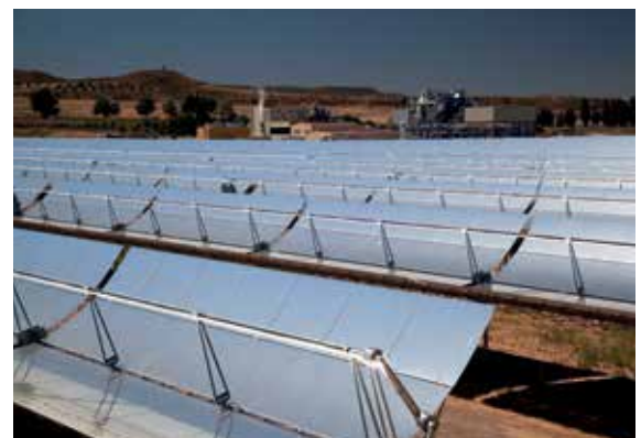
Planta termosolar de Les Borges Blanques (Lleida). Solar thermal power plant in Les Borges Blanques (Lleida).
