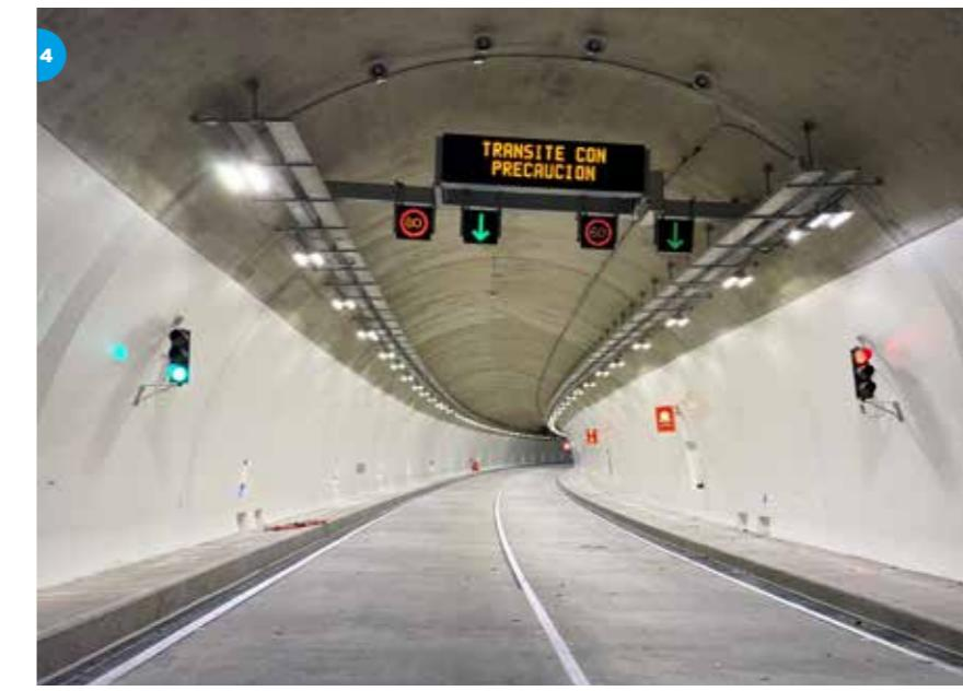
**4 Sistemas de control de tráfico, señalización dinámica, postes SOS, circuito cerrado de TV, control de ventilación, iluminación, control de energía y detección de incendios, para el tercer tercio del Corredor Bogotá - Villavicencio (Colombia).**
