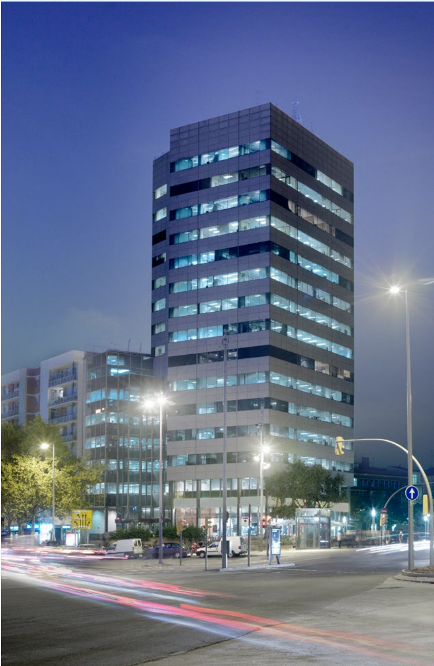
COMSA Corporación offices on Viriat Street, Barcelona (Spain). ►
