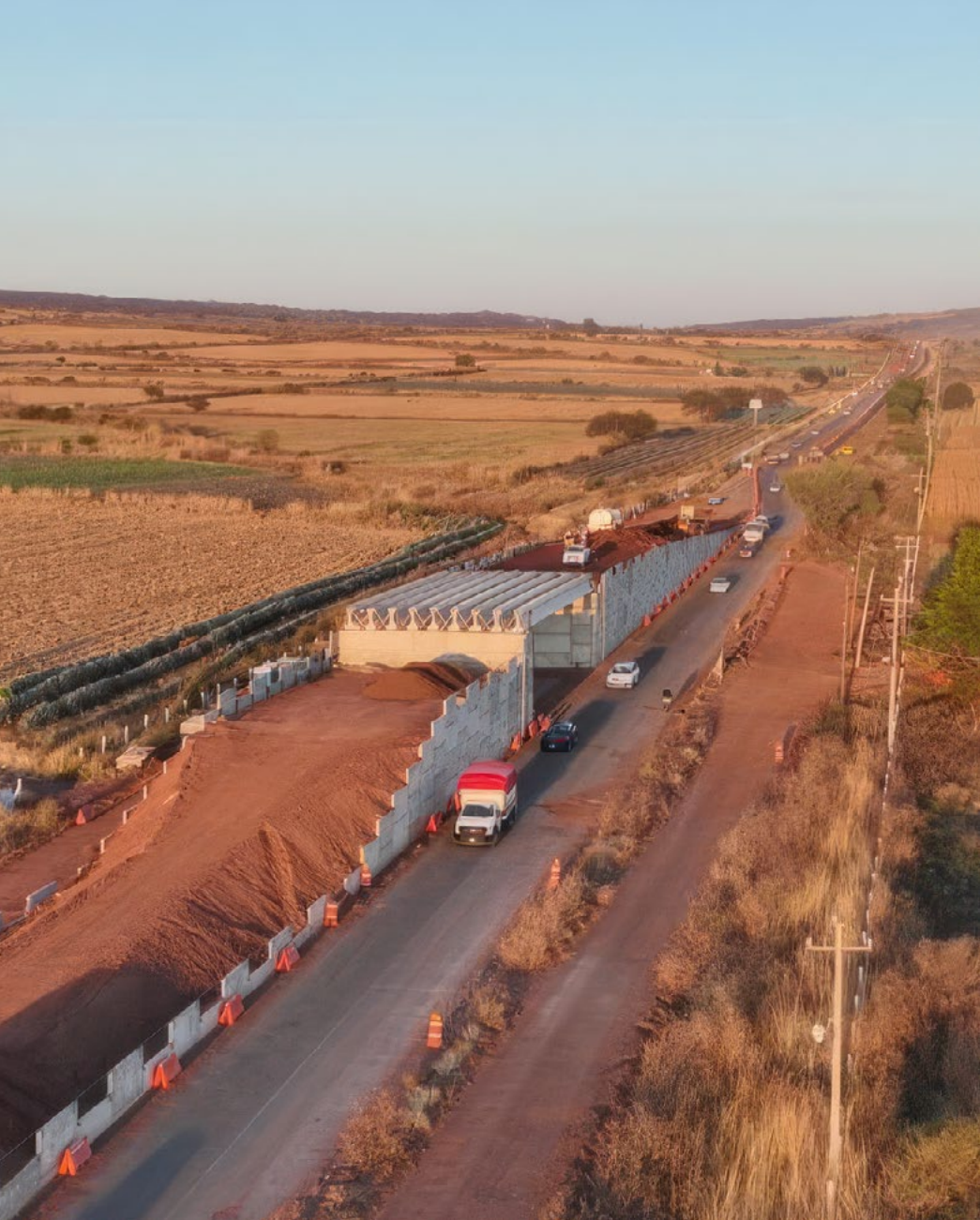
Modernization project for the Ecuandureo - La Piedad Road, Michoacan (Mexico). ▶
