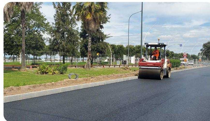
Construcción de carretera antifisuras con polvo de neumático de alto contenido en caucho reciclado, Huelva (España)
