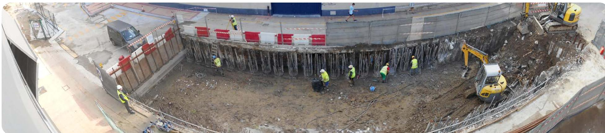
Preparación de la rampa para la ejecución del falso túnel en el proyecto del tanque de tormentas de Galindo, entre Barakaldo y Sestao (España)
