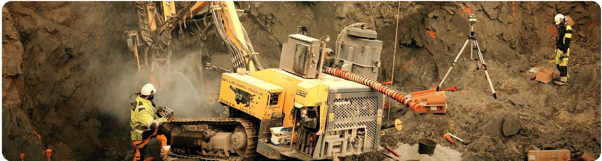
Perforación para la construcción de los túneles de acceso a la autopista E4, Skarholmen (Suecia)
