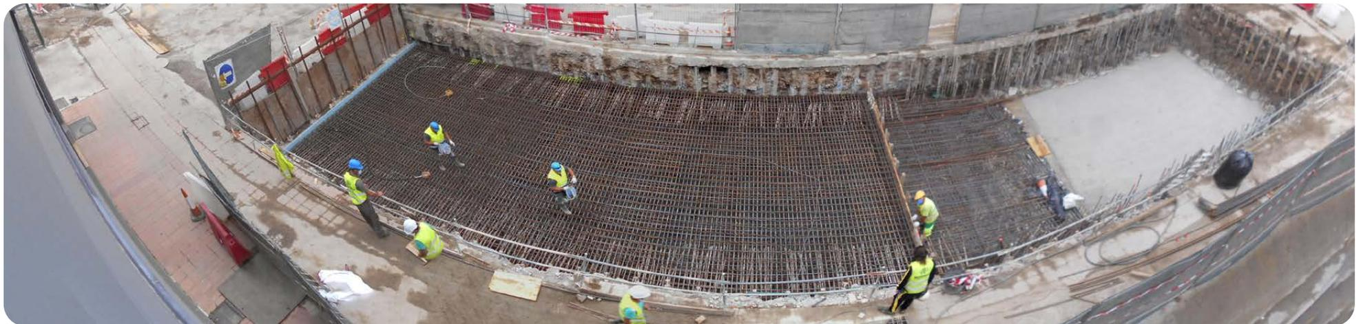
Construcción de la losa sobre la zona de ejecución del falso túnel en el proyecto del tanque de tormentas de Galindo, entre Barakaldo y Sestao (España)
