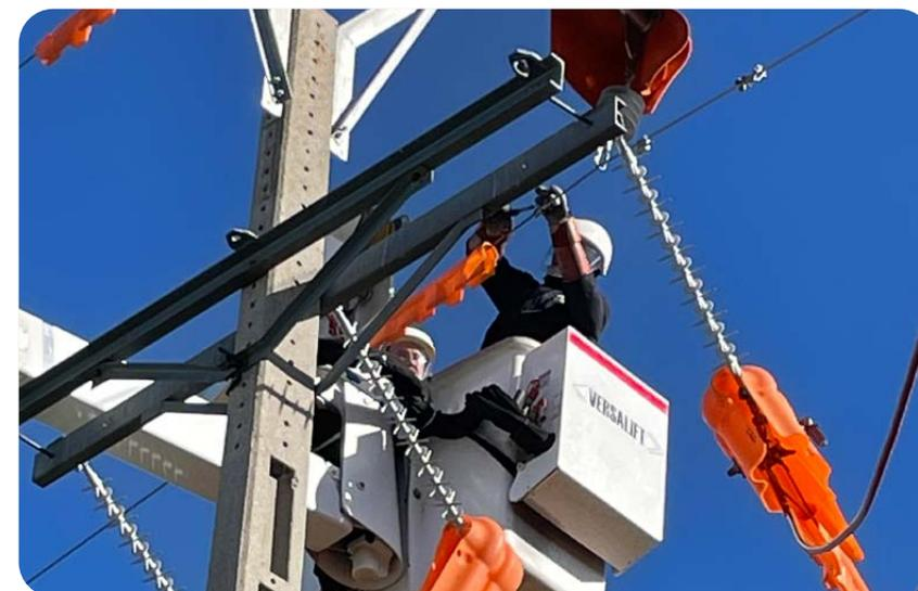
Instalación de protecciones en torres de media tensión, Salamanca (España)
