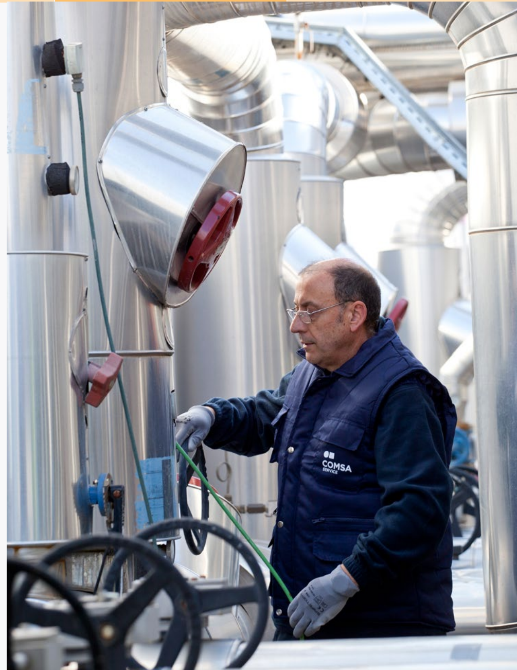
Operario de COMSA Service realizando el mantenimiento de instalaciones. ►
