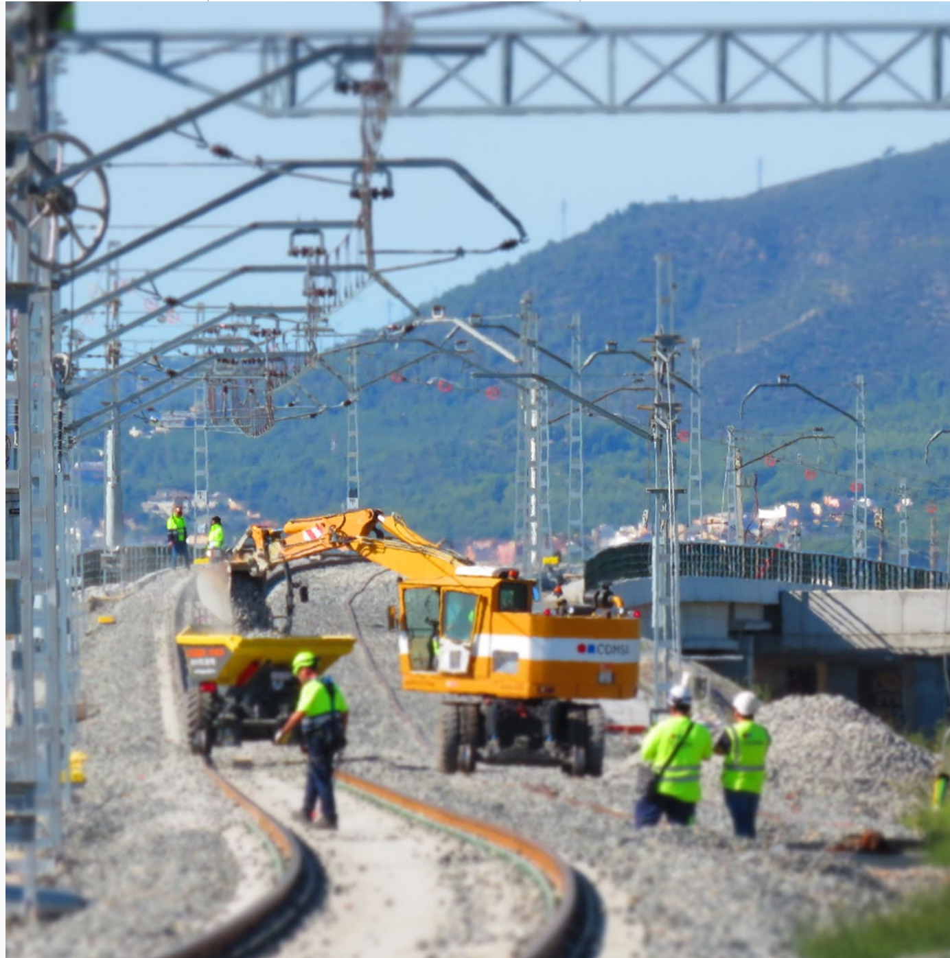
Obras de acceso Terminal 1 del Aeropuerto de Barcelona-El Prat, Barcelona (España).
