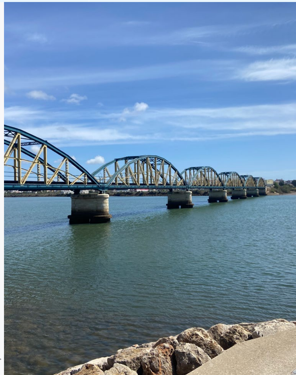
Electrificación de la línea ferroviaria realizada por COMSA (empresa constructora), COMSA Industrial (ingeniería) y FERGRUPO (filial del grupo en el país luso), Algarve (Portugal).
