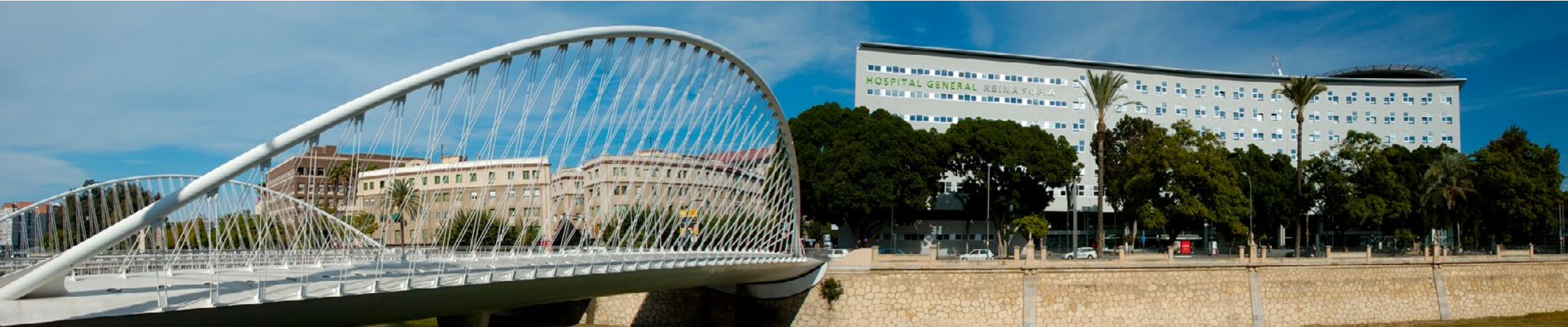
Mantenimiento realizado en el Hospital General Reina Sofía, Murcia (España). ▼
