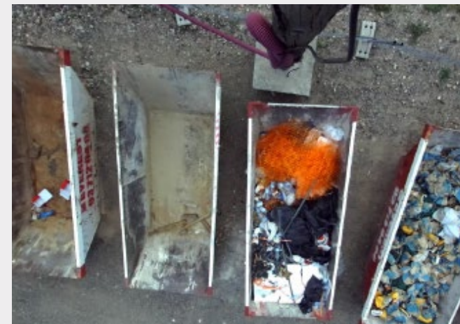
▲ Proyecto piloto en la obra de Prolongación de la Autovía del Baix Llobregat. Tramo Ronda del Litoral-Autopista A-16. Clave 49-B-4210T, Barcelona (España).
