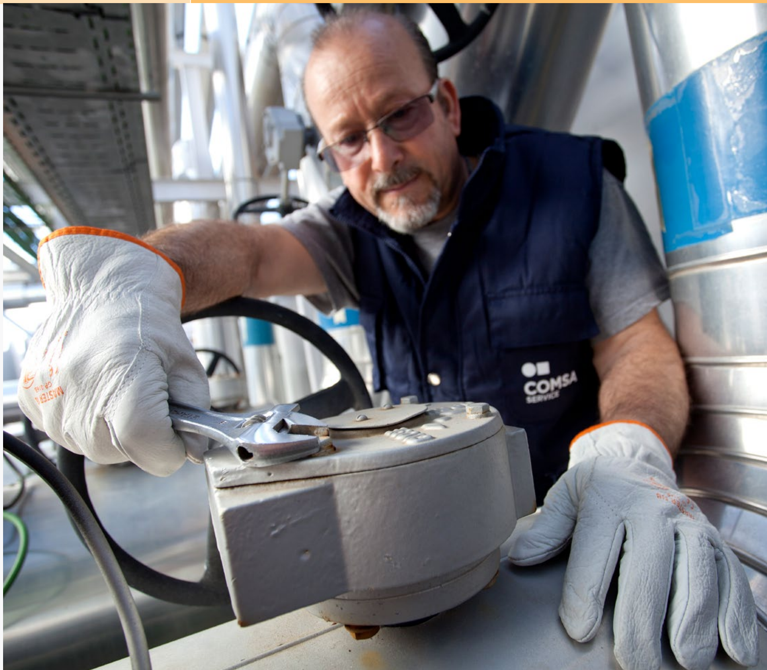
Trabajos de mantenimiento realizados por COMSA Service. ►
