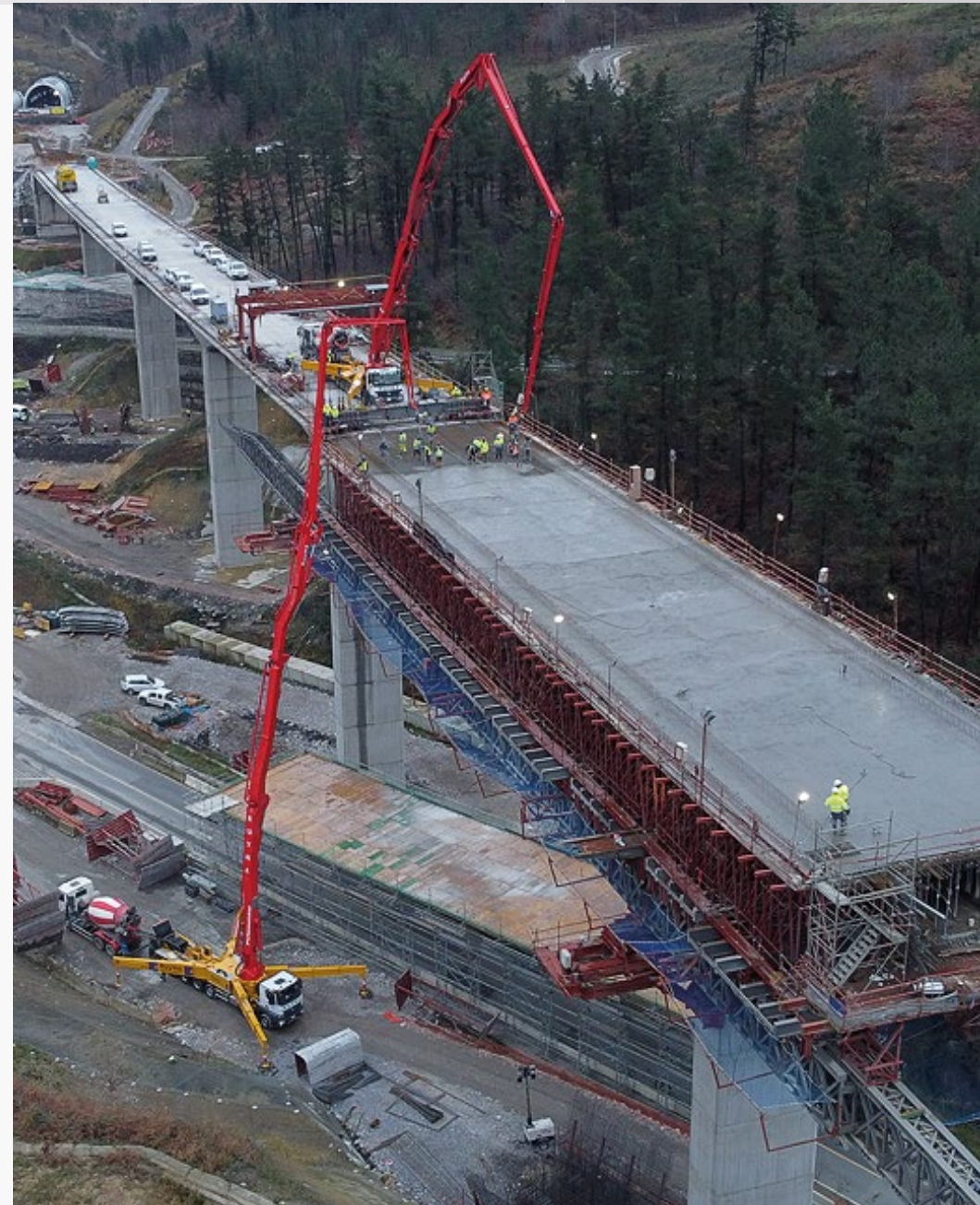
Ejecución del viaducto de Kortazar, dentro de los trabajos de construcción para la línea de alta velocidad vasca (Y vasca) (España).
