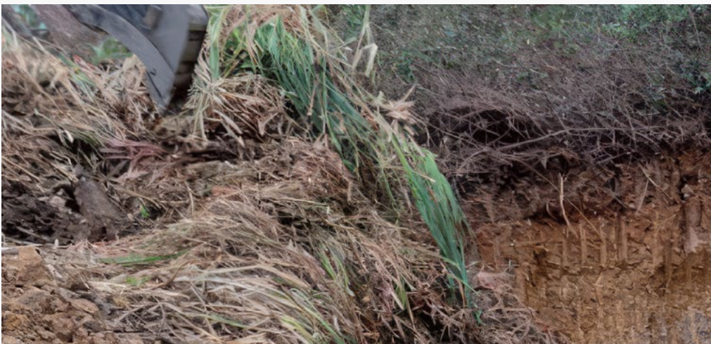
▲ Retirada de la especie invasora Cortaderia Sellonada en 2.274 m 2 para evitar su dispersión y mejorar la calidad del entorno de construcción. Bici pista del Ibaizabal tramo: Erletxes-Larrabetzu, Bizkaia (España).
