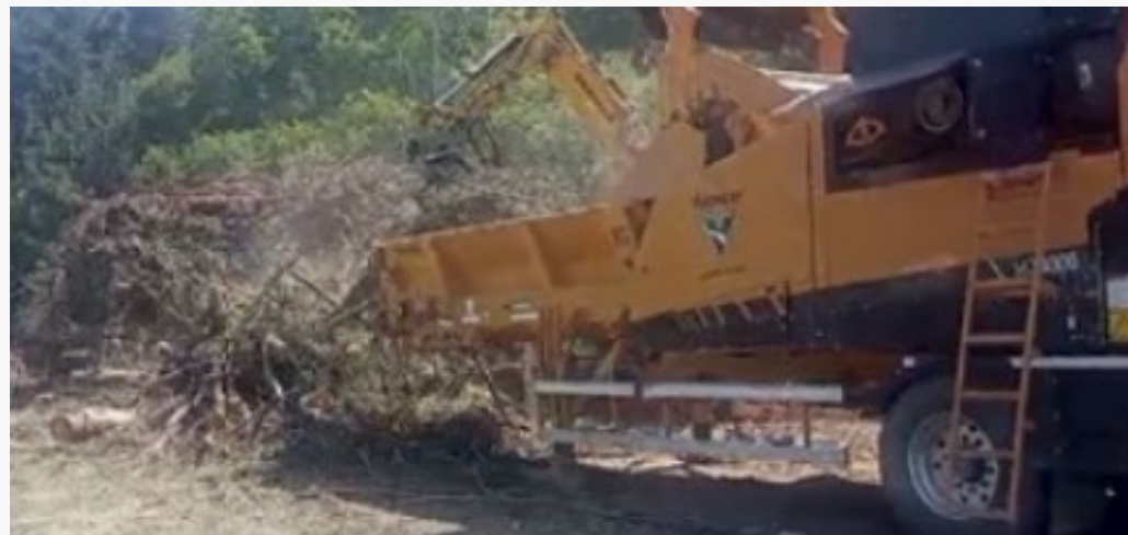
▲ Uso de material arbóreo procedente de tala para la mejora de la tierra vegetal de la obra, ayudando a retener el agua, mejorando la aireación y evitando la erosión.
