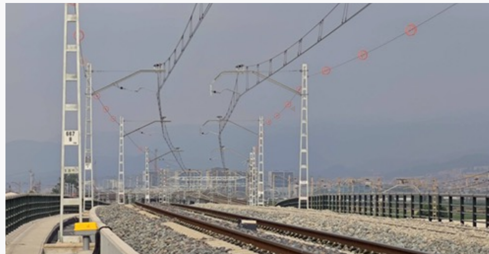
▲ Instalación 75 dispositivos salva pájaros en el acceso de cercanías a la terminal T1 del Aeropuerto de Barcelona (España).
