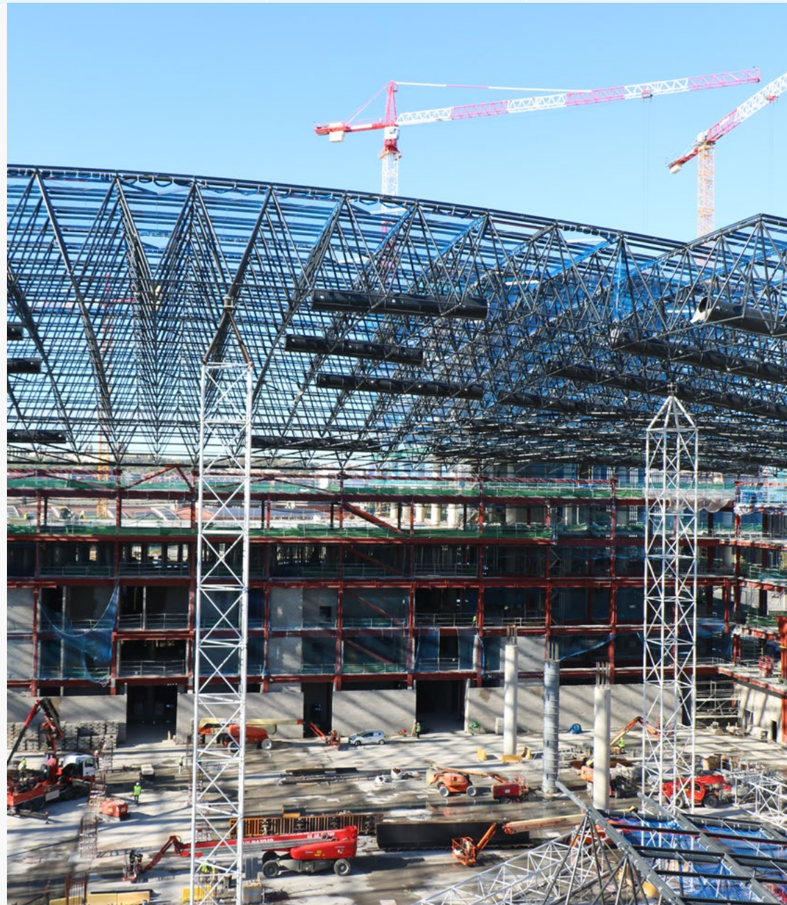
Construcción del nuevo pabellón Hall Zero de Fira Barcelona (España). ▶
