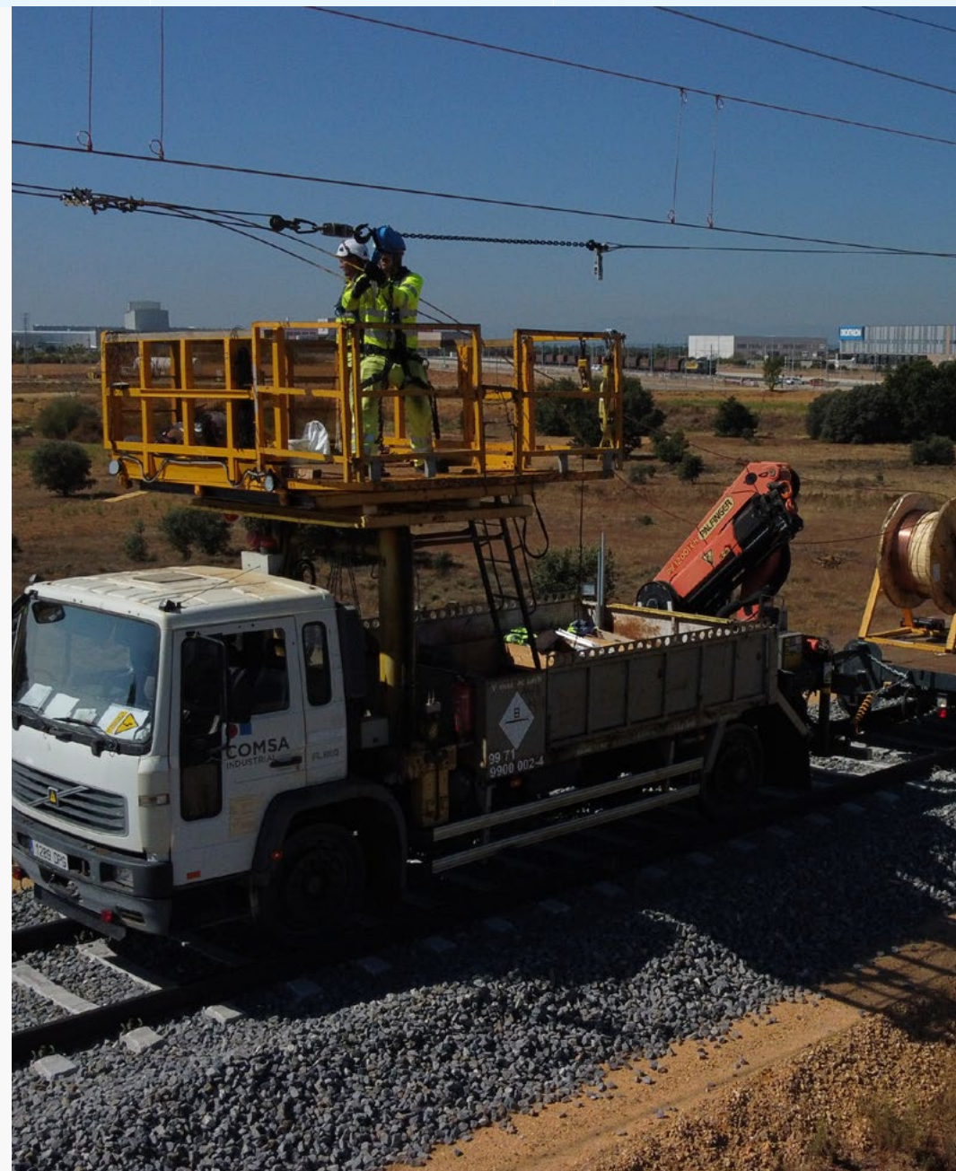
Tendido y tense de hilos de contacto en Villadangos, León (España). ▶
