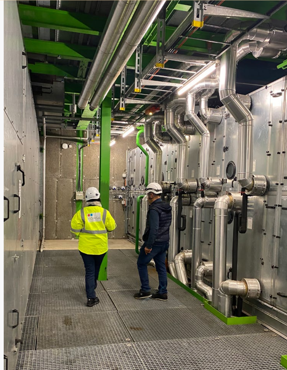
Mantenimiento de HVAC (Calefacción, ventilación y aire acondicionado) de Edificios Industriales en el CERN.
