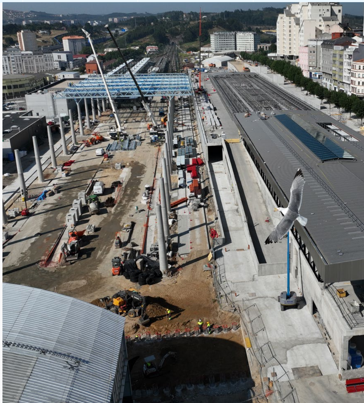
Construcción de la nueva estación de autobuses del área Intermodal, A Coruña (España). ▶
