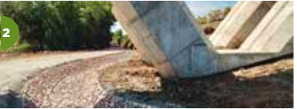
2 Restauración paisajística de ríos con el reaprovechamiento de 3.000 m³ de rocas provenientes del desmontaje de vías ferroviarias. Nueva conexión ferroviaria entre Évora Norte y Elvas/Caia (Portugal). Landscape restoration of rivers with the reuse of 3,000 m³ of rocks from the dismantling of railway tracks. New rail connection between Évora North and Elvas/Caia (Portugal).
