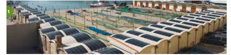
1 Instalación fotovoltaica y primera comunidad energética del Muelle de Pescadores, Port de Barcelona (España). Photovoltaic installation and first energy community of the Fisherman's wharf, Port de Barcelona (Spain).
