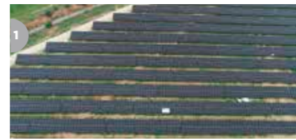
1 Nueva planta solar fotovoltaica en Constantí, Tarragona. New solar photovoltaic plant in Constantí, Tarragona.
