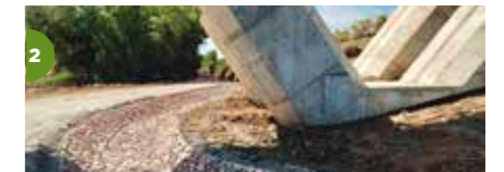
2 Restauración paisajística de ríos con el reaprovechamiento de 3.000 m³ de rocas provenientes del desmontaje de vías ferroviarias. Nueva conexión ferroviaria entre Évora Norte y Elvas/Caia (Portugal). Landscape restoration of rivers with the reuse of 3,000 m³ of rocks from the dismantling of railway tracks. New rail connection between Évora North and Elvas/Caia (Portugal).
