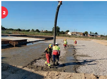
2 Construcción del sistema de colectores y la estación depuradora de Torrefarrera y Torre-Serona, Segrià (Lleida). Construction of the collectors system and the treatment plant of Torrefarrera and Torre-Serona, Segrià (Lleida).
