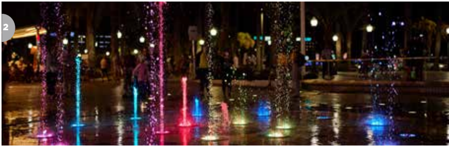
2 Instalação de fontes transitáveis no passeio da Explanada, em Alicante.
