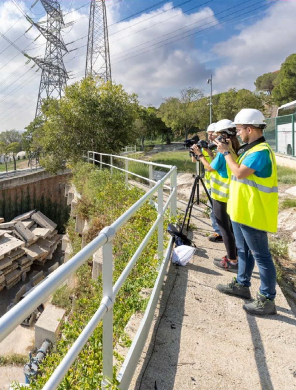
Recolección de datos en una obra de rehabilitación para el proyecto europeo ► RECONSTRUCT en Barcelona (España).
