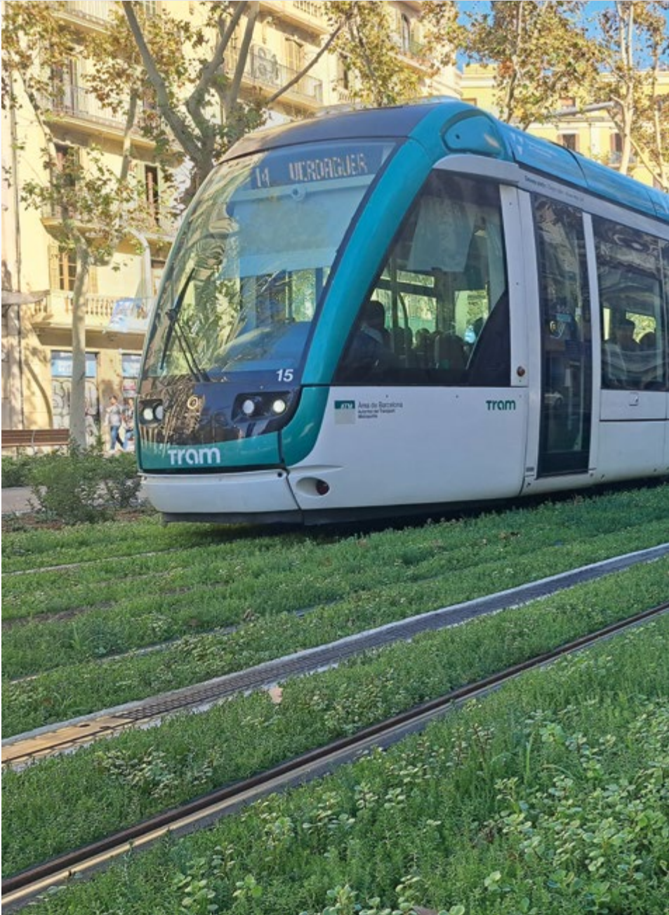
Finalización del tramo Glòries - Verdaguer ► del tranvía de Barcelona (España).
