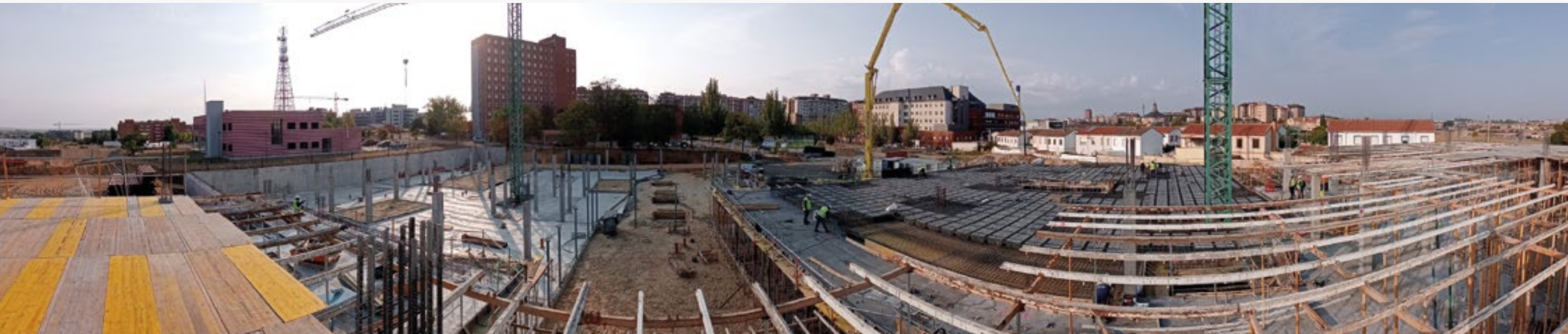
Imagen panorámica de los trabajos de la construcción de la nueva residencia para mayores, en Zamora (España). ▼
