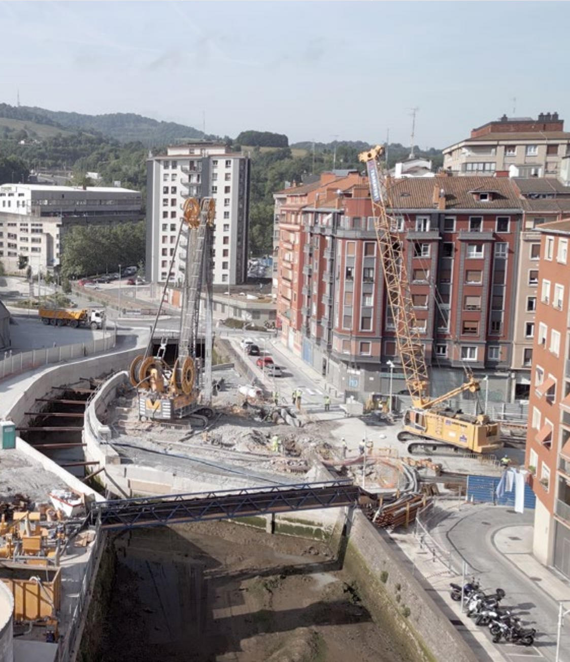
Trabajos en el tramo Altza - Galtzaraborda del Metro de Donostia (España).
