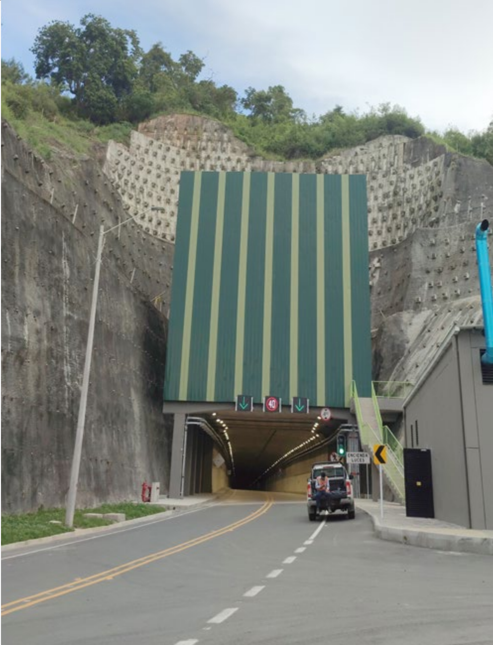
Túnel de Tesalia, el más grande del proyecto Autopista Conexión Pacífico 3 (Colombia).
