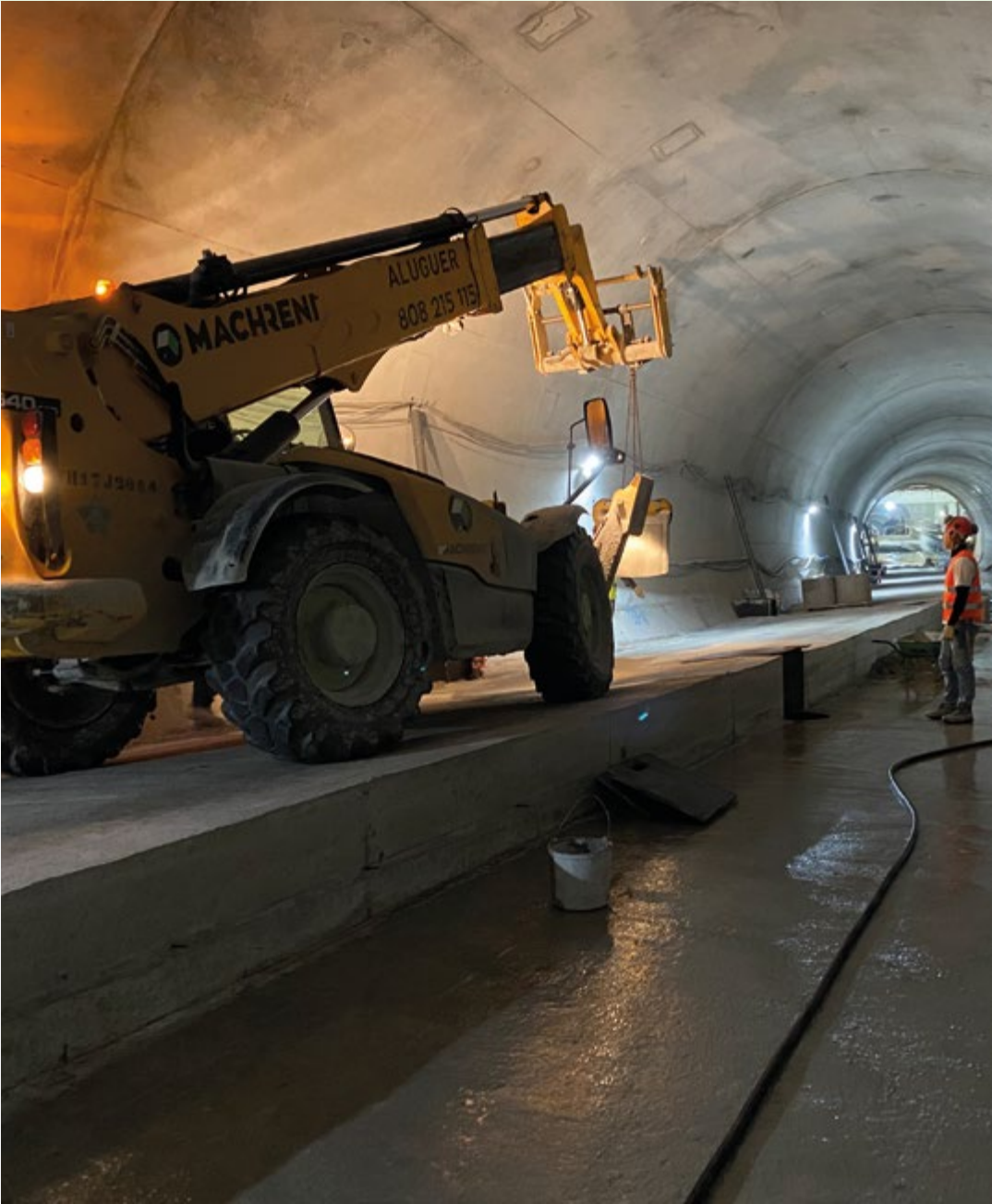
Proyecto de expansión de las líneas Amarilla y Verde del Metro Lisboa (Portugal). ▶
