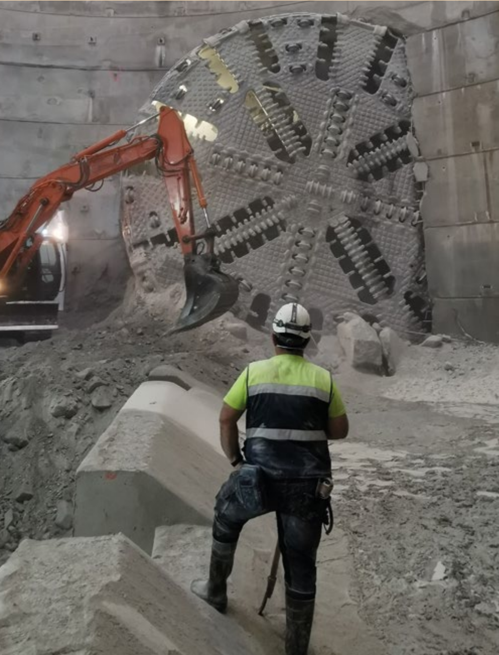
Cale del túnel de Mandri, en la L9 de Metro de Barcelona (España). ►
