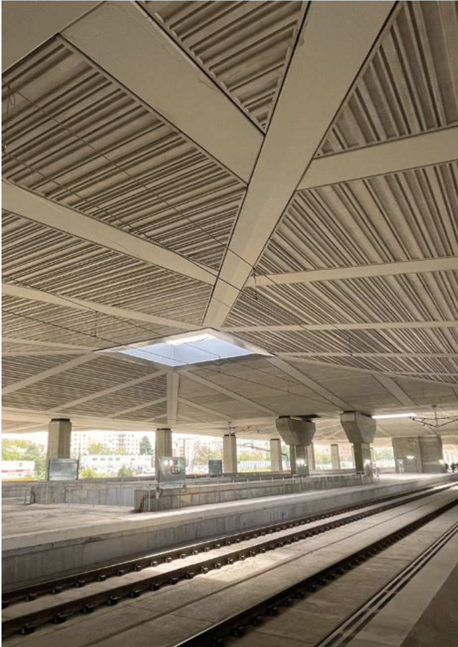
Construcción de la estación de AVE de La Sagrera, Barcelona (España). ►
