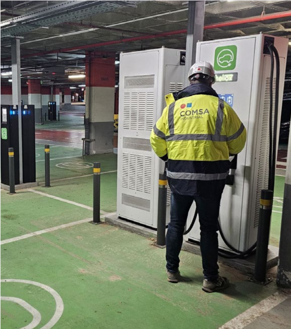
Instalación de más de puntos de recarga para vehículos eléctricos en los aeropuertos de Barcelona y Madrid utilizando la metodología BIM para optimizar la gestión durante todo su ciclo de vida de la instalación (España).
