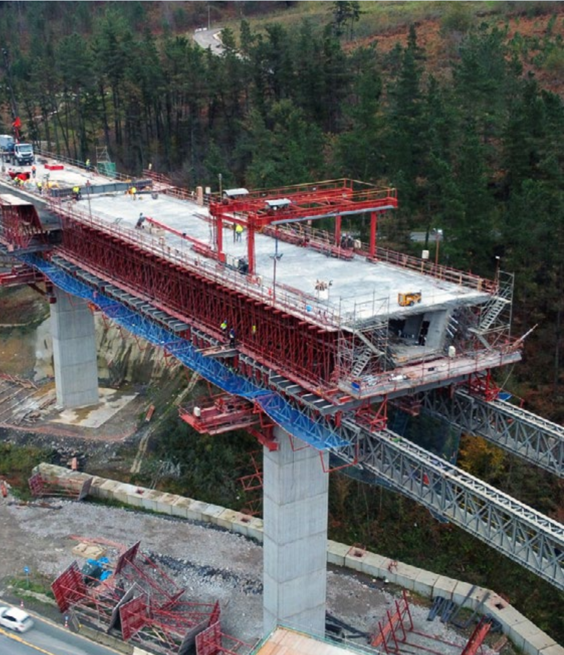
Construcción del sector 3 del ramal Mondragón, Elorrio y Bergara ► correspondiente a la alta velocidad vasca “Y Vasca” (España).
