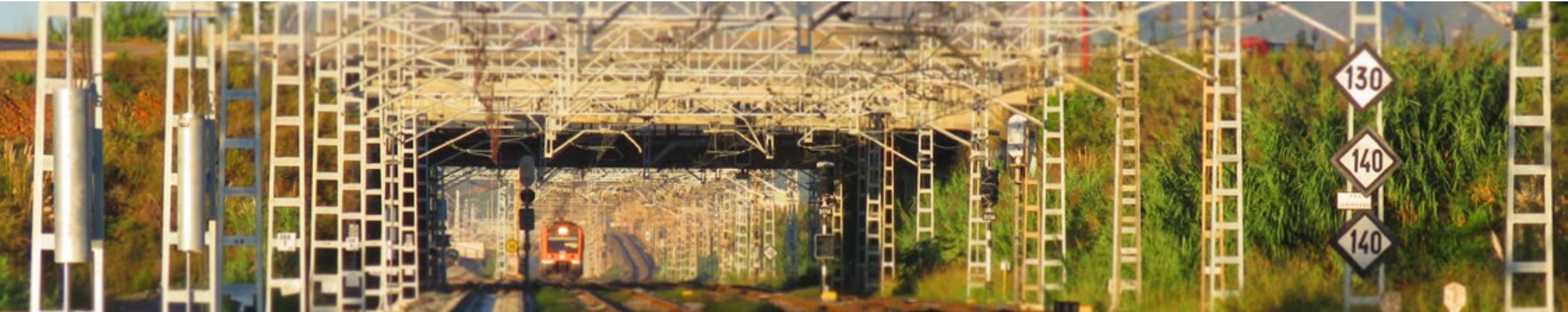
Renovación de catenaria en el acceso ferroviario a la T1 del aeropuerto de Barcelona - El Prat (España). ▼
