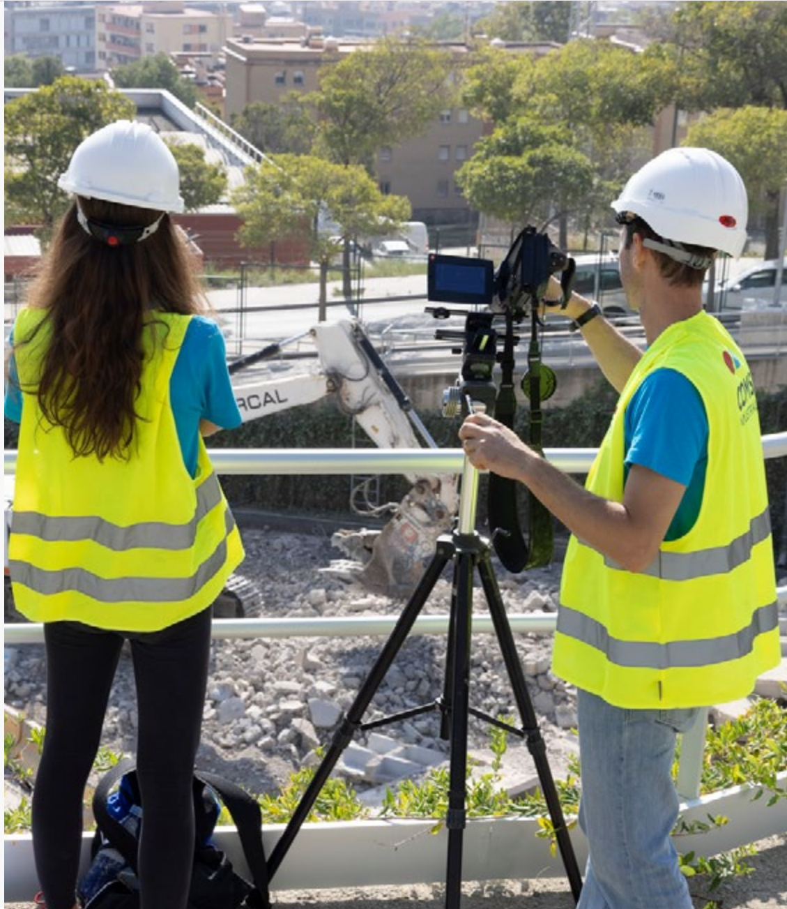
Recolección de datos en una obra de rehabilitación para el proyecto europeo ► RECONSTRUCT en Barcelona (España).
