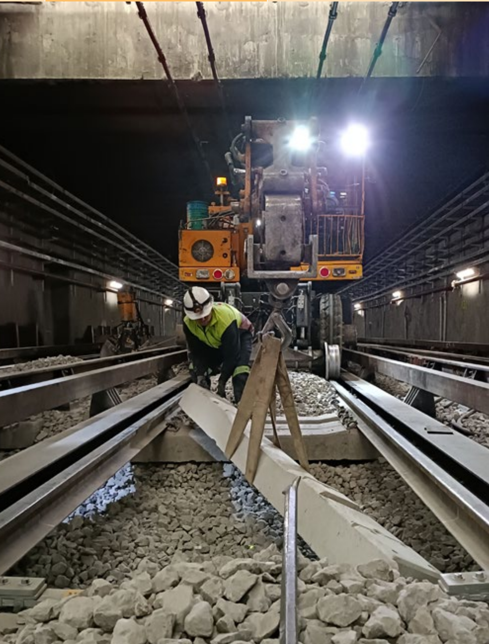
Rehabilitación y mantenimiento de vías y sistemas de la Línea 1 del Metro de Ciudad de México (México).
