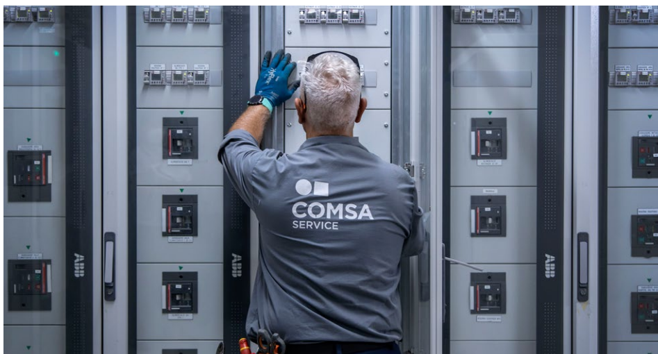
Operaciones de mantenimiento en edificios (España)
